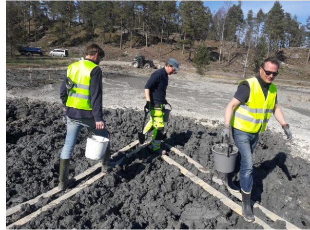
Naantali, Matalahti 2020. Maalle läjitetty ja stabiloitu ruoppausmassa.
