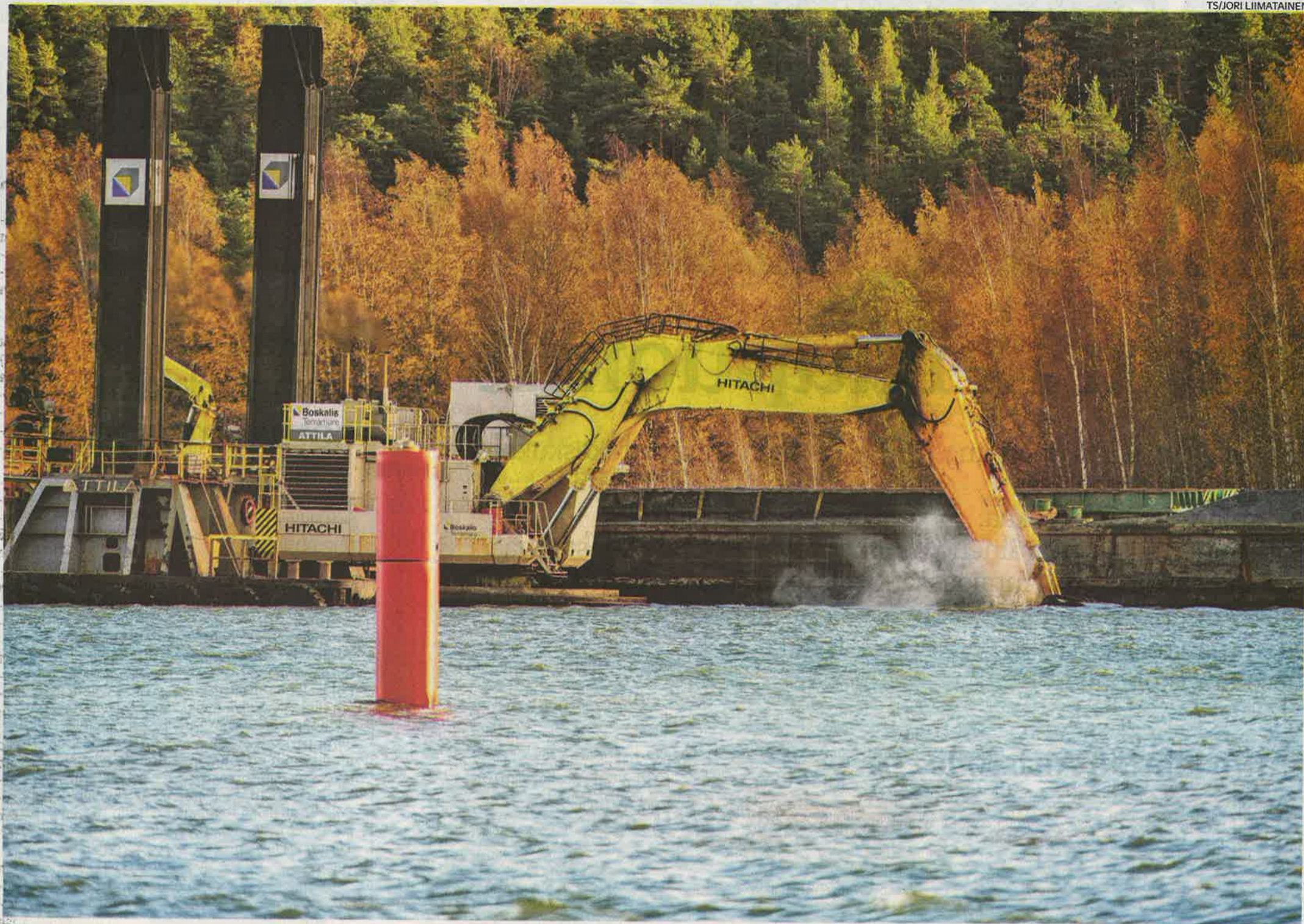
Turun satama-allasta ja Pukinsalmea ruoppaa Terra Maren Attila-kuokkaruoppaaja. Apuna on monia muita aluksia.
